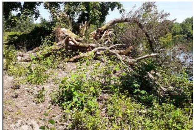
12 - Stockage de bois à l'aplomb du seuil aval n°1 entre le plan d'eau N°2 et le merlon
