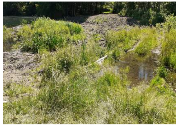
16 - Seuil inter-bassin 1 et 2 avec arbres pour passage à guet et retenue d'eau
