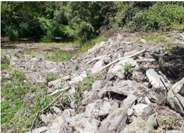
15 - Seuil aval n°1 versant Moselle à gauche
