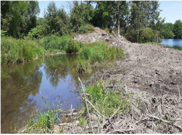
13 - Seuil aval 1 et vue de coupe du merlon
