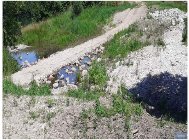
8- Seuil n°3 inter-bassin n°1-3
