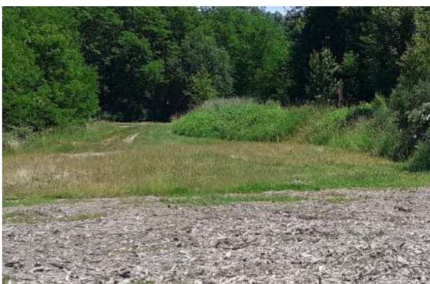
5 - Bande terre entre merlon et plan d'eau n° 1 (Parcelles B 1521, B1522 - seuil amont)
