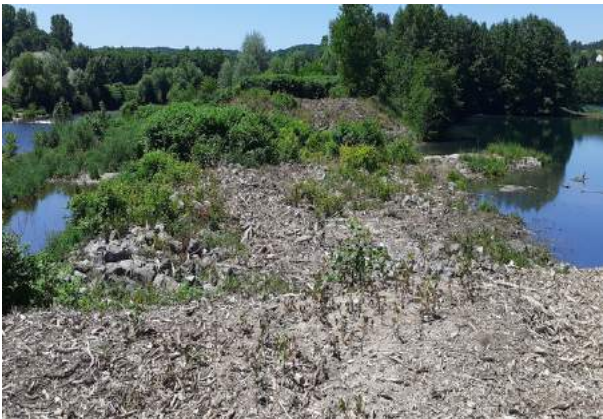
3 - Seuil amont entre la Meuse et l'étang n° 1
